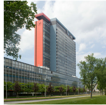
図 1 TU Delft EEMCS 学部の建屋
