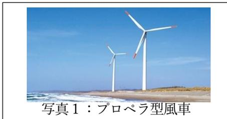
この風車には、大規模なので発電効率が良いという長所があるが、短所も存在する。1つ目は、特定の方向からの風にしか対応できず、1年を通して多方向から風の吹く日本では、能力を最大限に発揮できない点。2つ目は、回転に大きな力が必要な点。3つ目は、国土の狭い日本では、大規模風力発電機を設置する土地の確保が難しい点。4つ目は、大きな羽が回転するため、騒音が発生し近隣住民の迷惑になる点だ。私たちはこれらの短所を解決すべく、日本の環境に適した風力発電機の作成を目指した。
